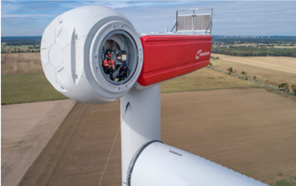
Nachhaltigkeit durch hocheffiziente Energieerzeugung: Mitarbeitende bei der Errichtung einer Delta4000 N149/5.X in Genshagener Heide, Deutschland
